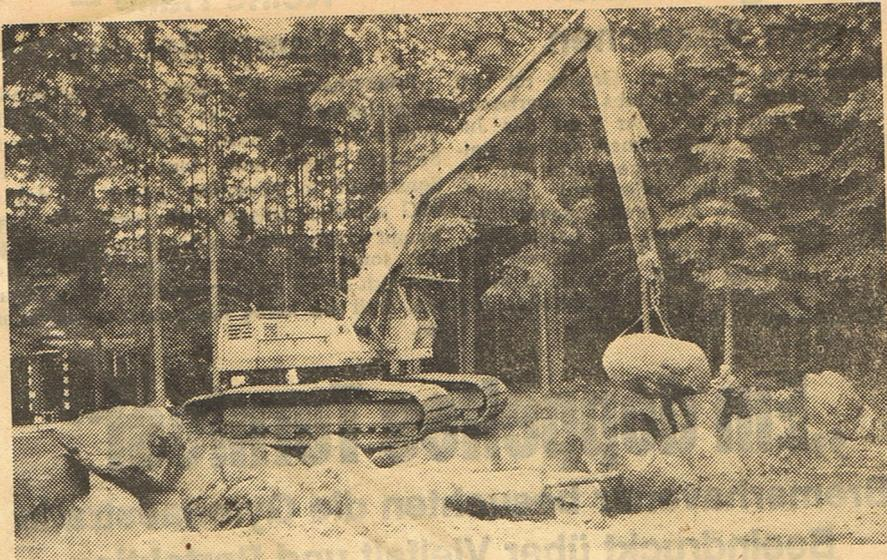
Der Hydraulikbagger hebt einen sechs Tonnen schweren Deckstein wieder auf die Träger.
